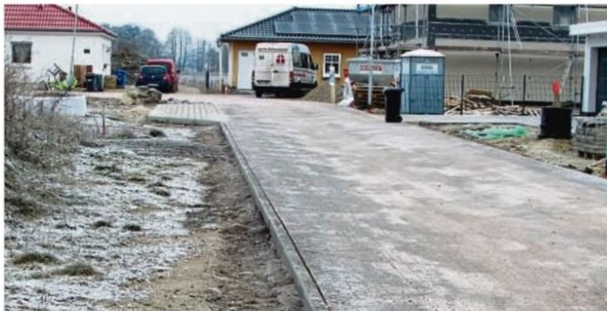
Der Ausbau der Straße Lübkesfeld im Baugebiet Schwerinsfeld III ist fast abgeschlossen – bis auf die Seitenräume.
