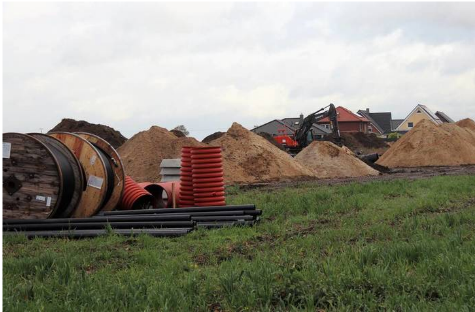
Tülau: Die Erschließungsarbeiten im neuen Baugebiet an der Hauptstraße sind in vollem Gang. Als neuer Name wurde „Lübkesfeld“ festgelegt. Foto: Michalzik
