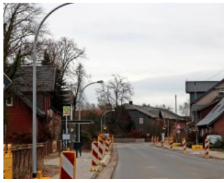
Modernisierung der Straßenbeleuchtung: In Voitze werden ab kommendem Frühjahr Laternen auf LED-Technik umgestellt. Peter Zur
