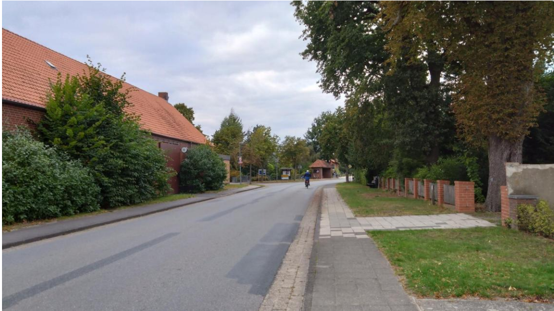
Abb. 6 Auf der rechten Seite der Hauptstraße sollen unter Beachtung der Zufahrten und des Fußweges Stellplätze für den ruhenden Verkehr entstehen. Eigenes Foto.
