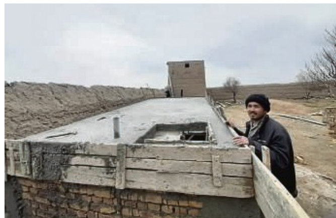
Der Verein Katachel finanziert den Bau einer Zisterne in der Provinz Kunduz.
