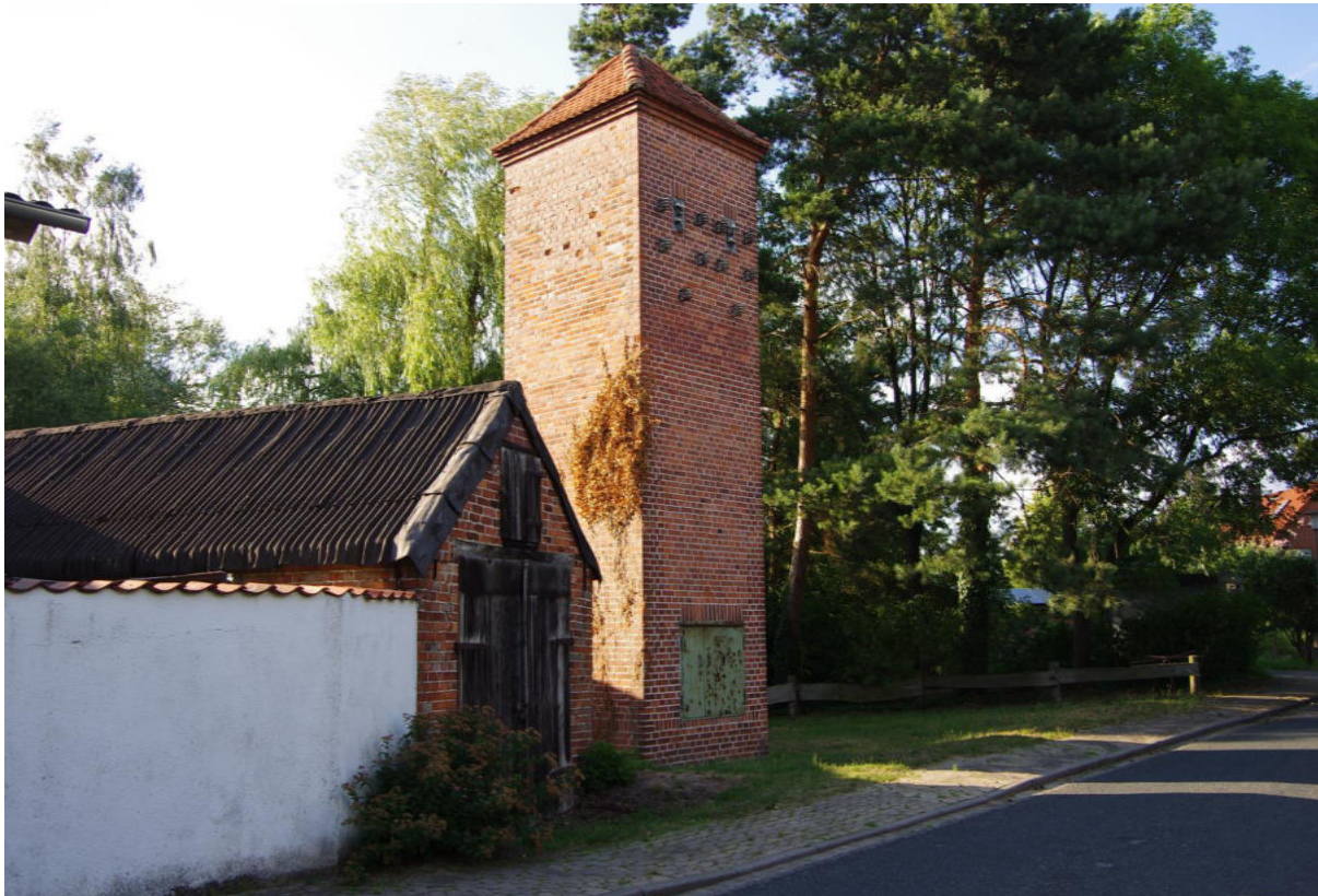
Das ehem. Spritzenhaus mit Trafoturm in Voitze.
