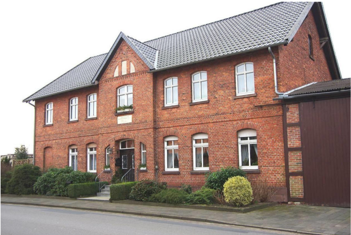
Prägender Altbau in Tüla, der dem Baubild entsprechend saniert wurde.
