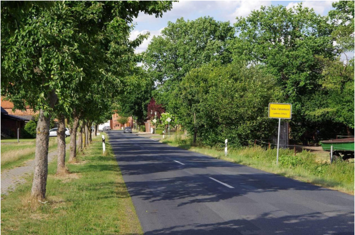
Geradliniger Ortseingang der K 90 aus Richtung Bergfeld.
