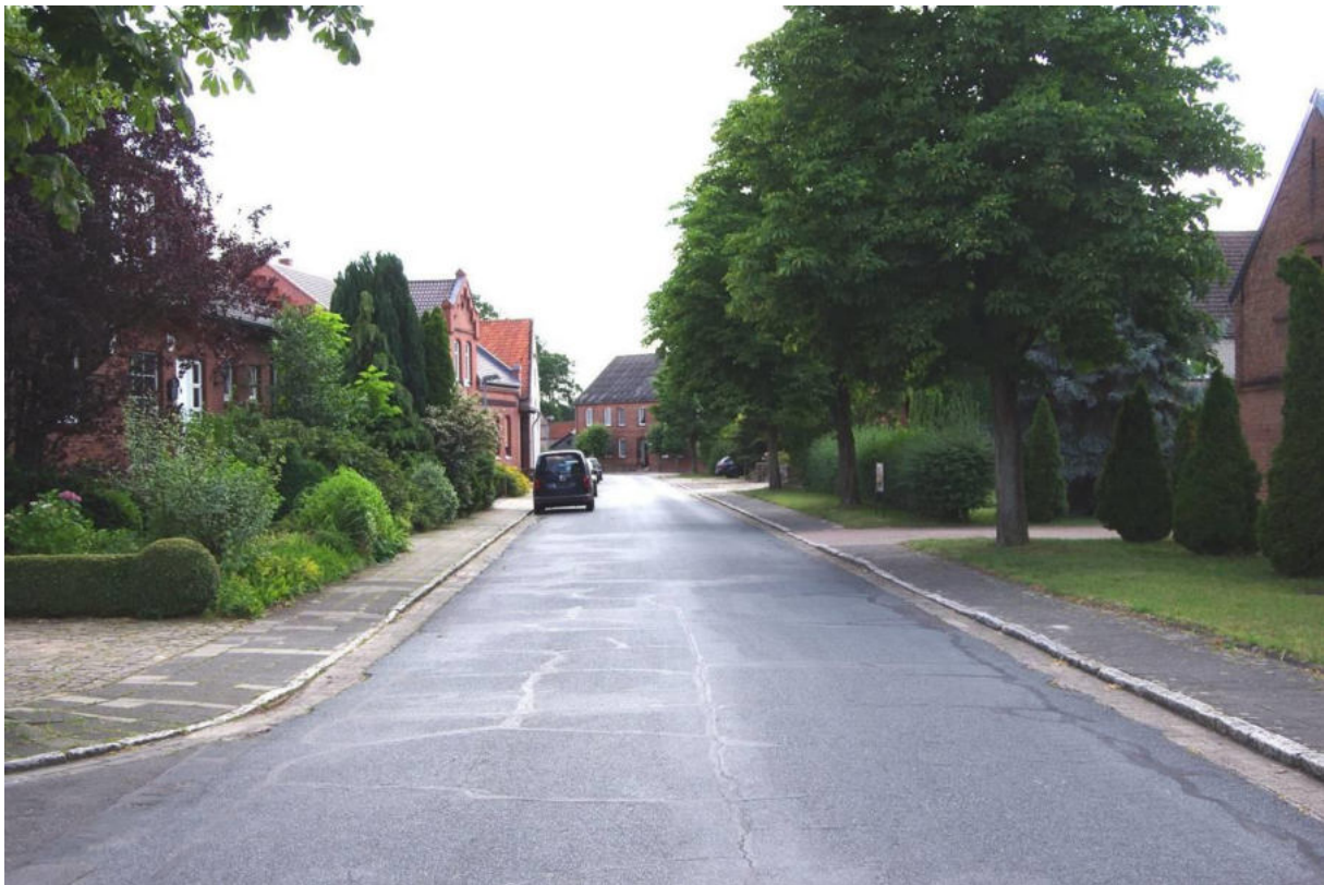
Die Straße Bauernende in Tüla zeigt zunehmenden Sanierungsbedarf.
