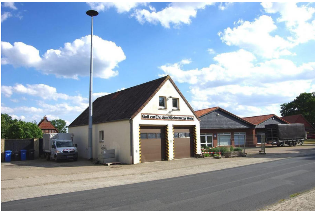
Der ehem. Feuerwehrstandort in Tülau wird zurzeit als Bauhof genutzt.
